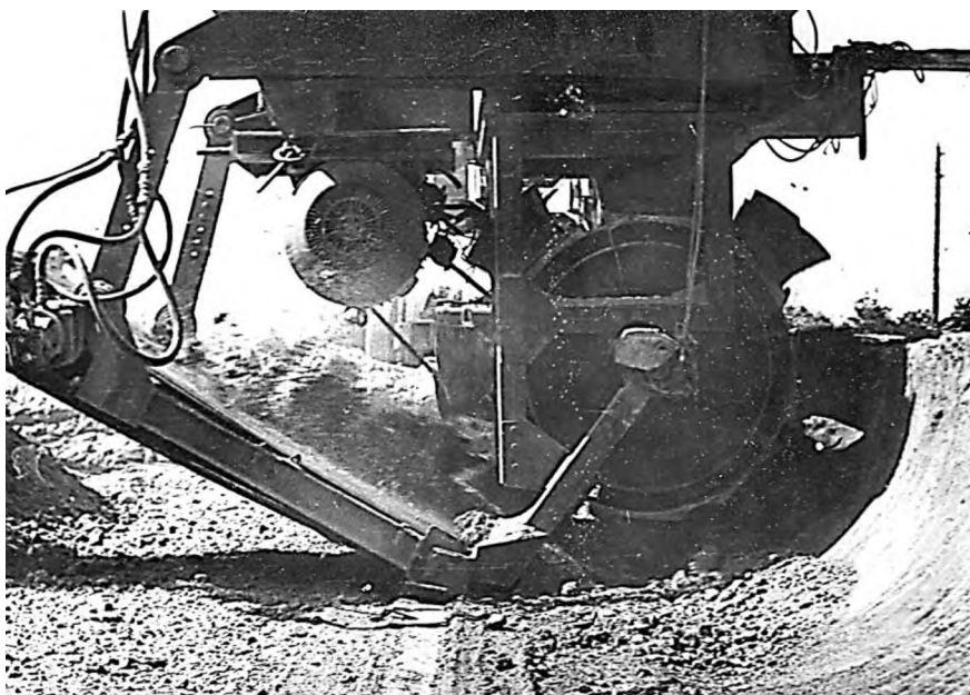
Рисунок 2 – Ножевой бесковшовый ротор нижней разгрузки диаметром 1,54 м в забое
