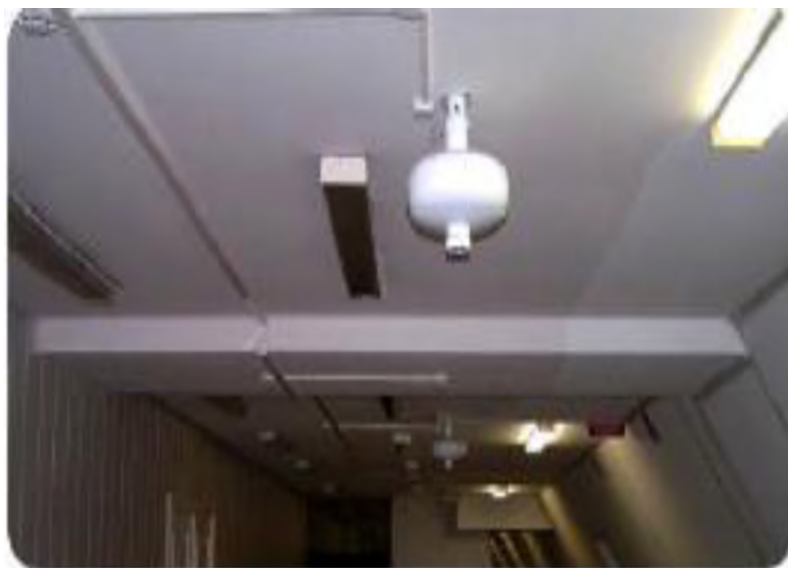
Рисунок 3 – Порошковая система пожаротушения
